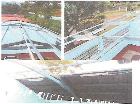
Foto 1: Se empieza con el trabajo de cambio de estructura por costaneras de METAL
