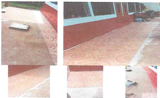
Foto 3: Empiezan a realizar el trabajo de sustitucion de torta de cemento por piso cerámico antideslizante en el corredor
