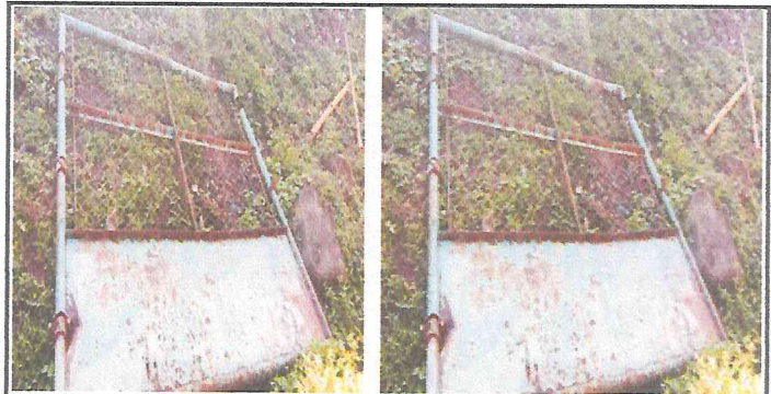
Foto 6: Se elimina portón para reemplazo de un nuevo
