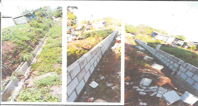
Foto 5: Se inician los trabajos en el muro perimetral
